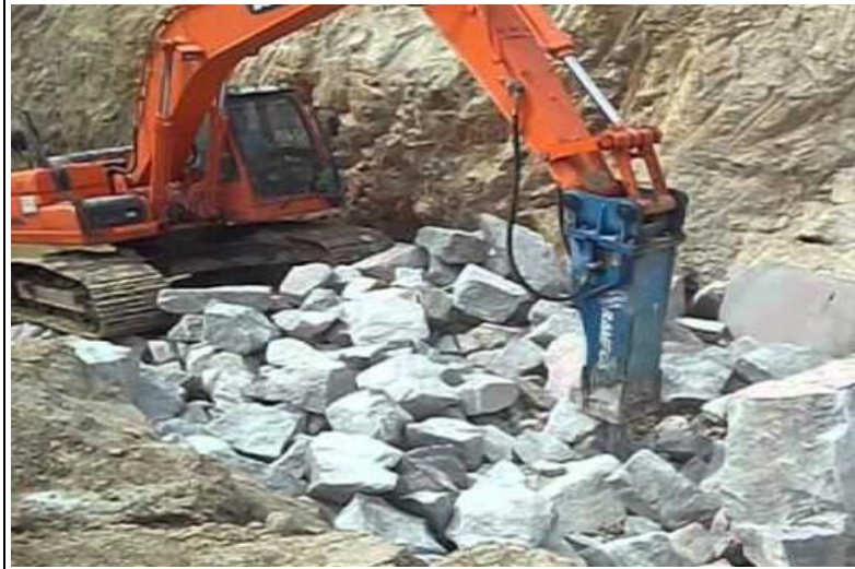
Equipamentos para desmonte de rocha (3ª categoria) - Escavadeira hidráulica com rompedor hidráulico
